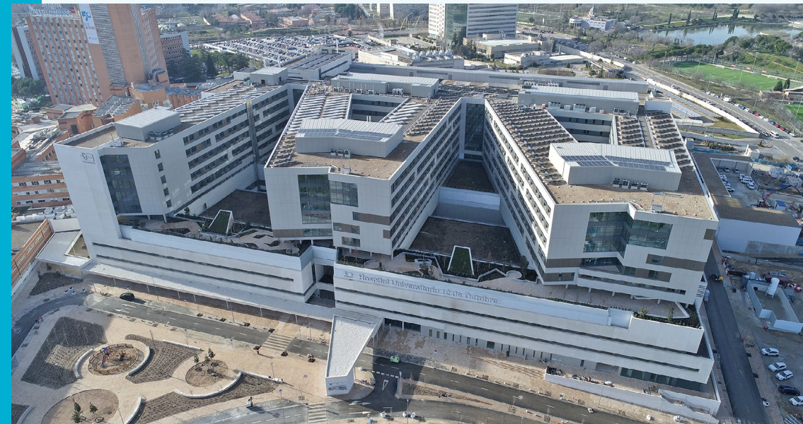
Hospital Universitario 12 de Octubre. Spain
