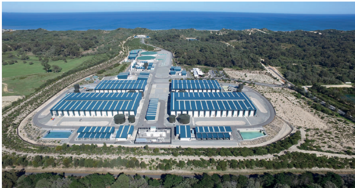
Planta Desaladora de Perth. Australia
