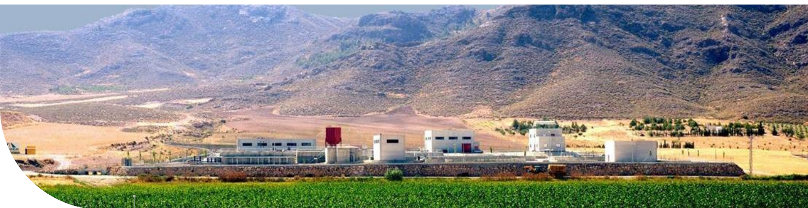
Estación depuradora de aguas residuales de Jumilla
