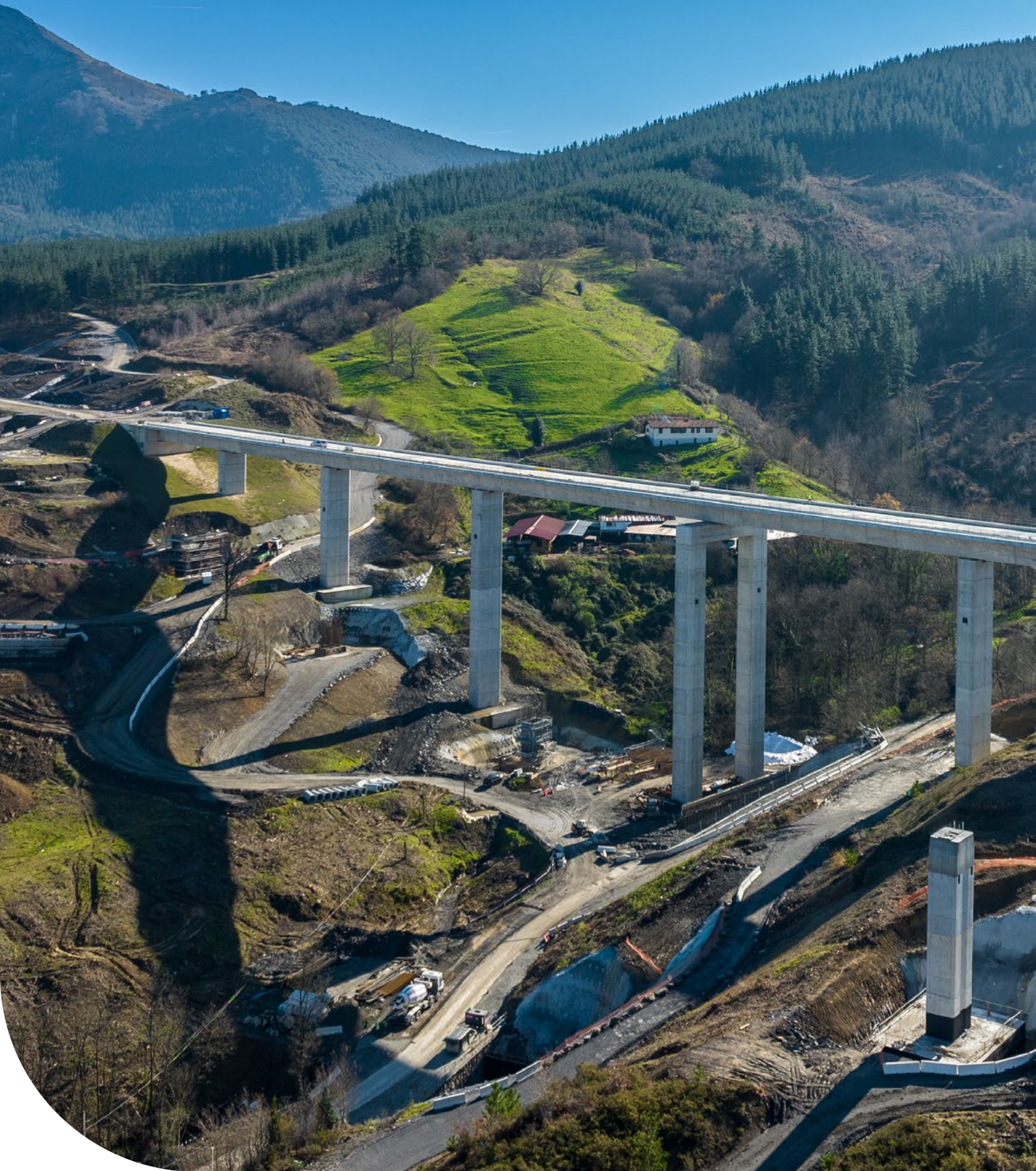
Imagen del proceso de construcción del proyecto UTE Elorrio en Vizcaya.
