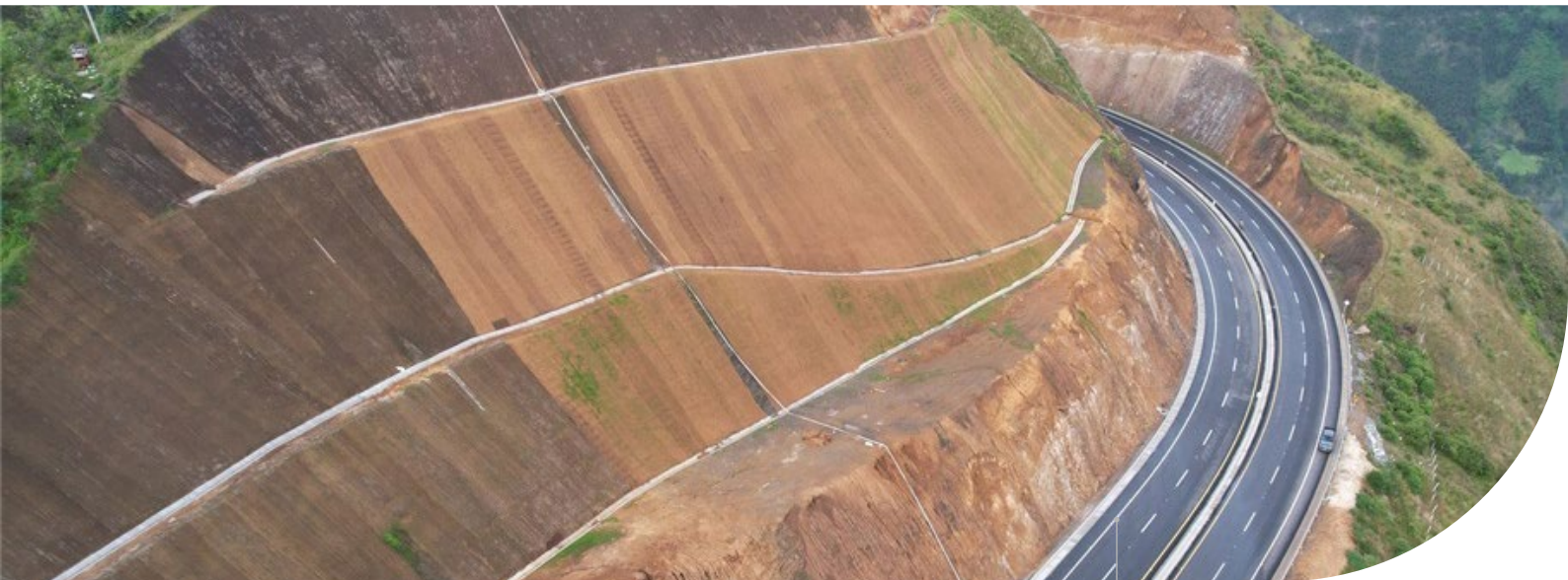
Intervención en el proyecto Doble Calzada Rumichaca-Pasto (Colombia) con la instalación de biomanto de fibra de coco.
